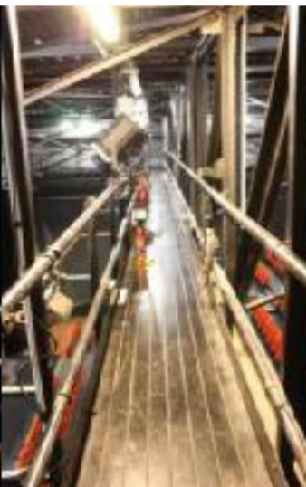
la passerelle face
