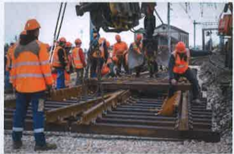
Renouvellement d'aiguillages
