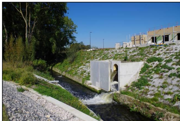
Ru de Gally – Au niveau de l'exutoire de la station d'épuration du Carré de Réunion à Saint Cyr l'Ecole
