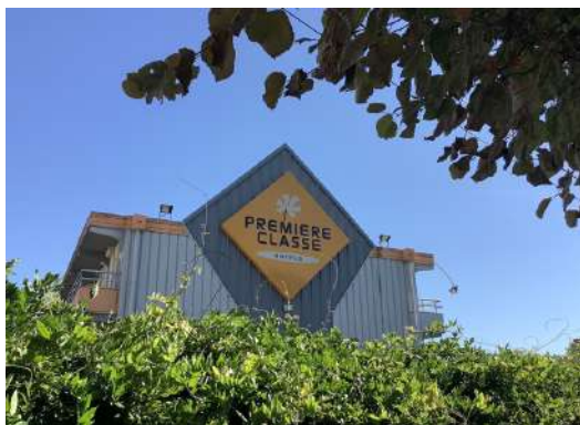
Enseigne dépassant les limites de l'égout du toit
