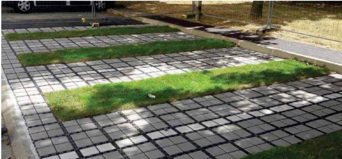
Figure 46 : Prototype éco-végétal en phase d'installation – juillet 2020
