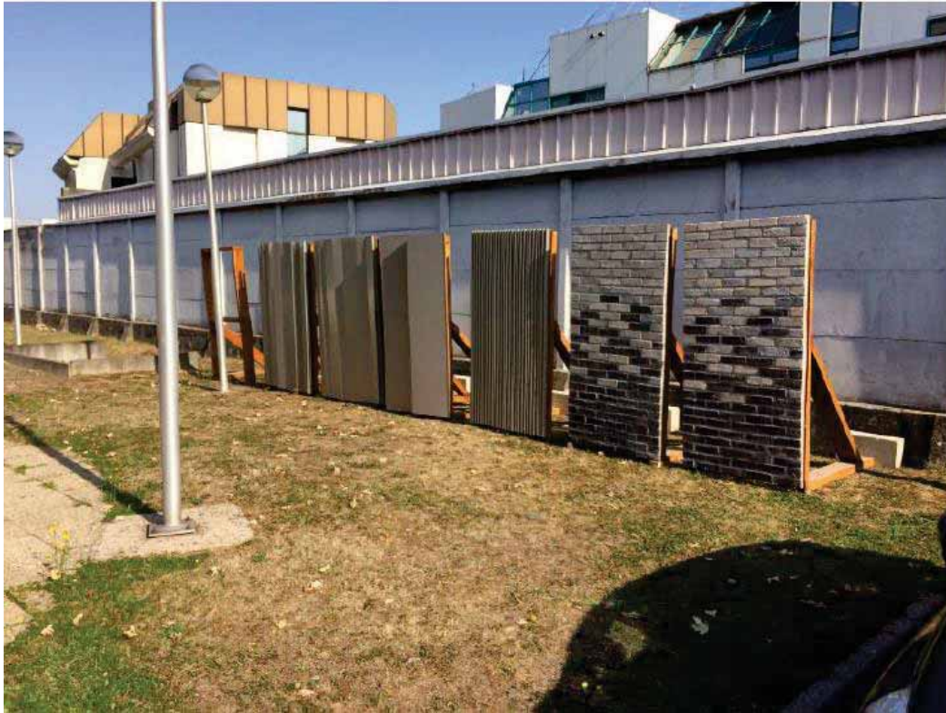
Figure 62 : Échantillons de façade installés le 17/09/2020 au siège des Résidences
