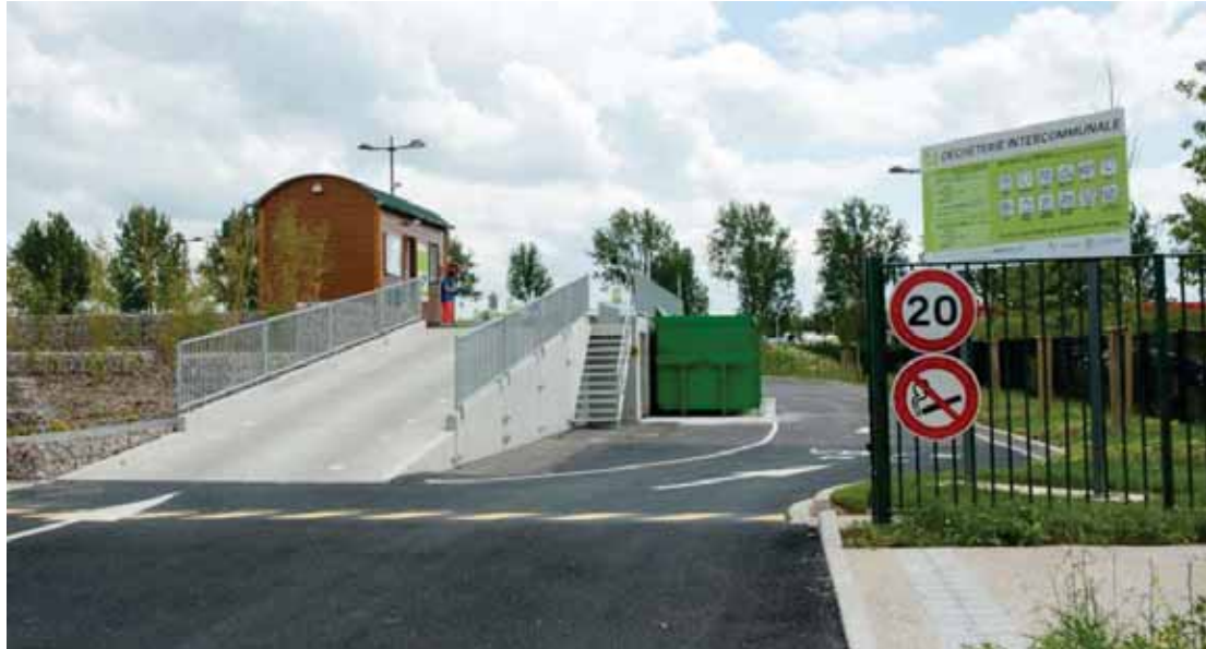
Photo 10 : Déchèterie intercommunale de Bois d'Arcy
