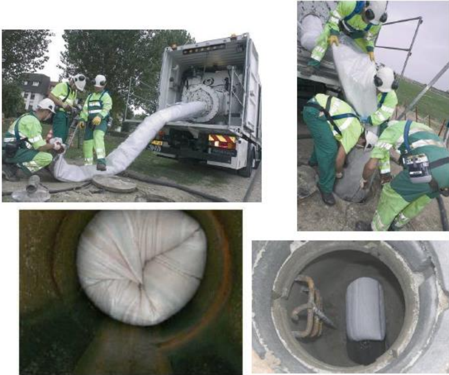
Exemple de travaux de chemisage
