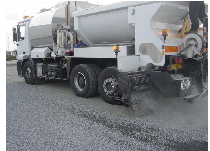
Exemple de gravillonnage à l'émulsion
