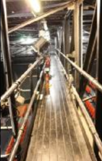
la passerelle face
