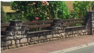
Soubassement pierre surmonté d'une clôture bois
