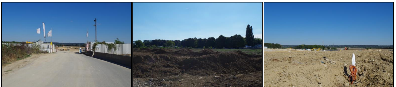
Entrée du chantier
