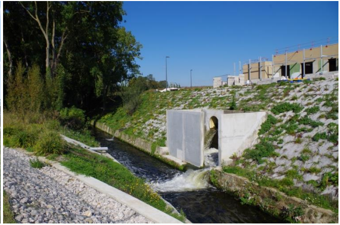
Bâtiments en construction
